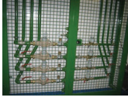
نظام تقسيم المياه المستعمل في مركز تسوق
