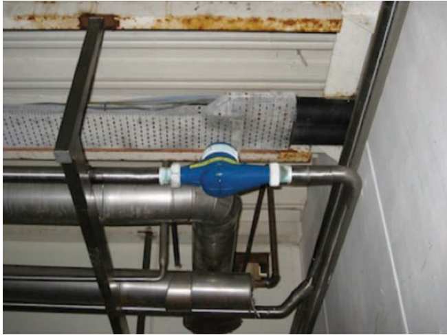
أحد عدادات المياه الجديدة التي تم تركيبها
