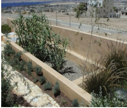
المستنقع (حوض الترشيح) بعد 6 أشهر من العمل. بدأ العشب وقصب الخيزران بالنمو
