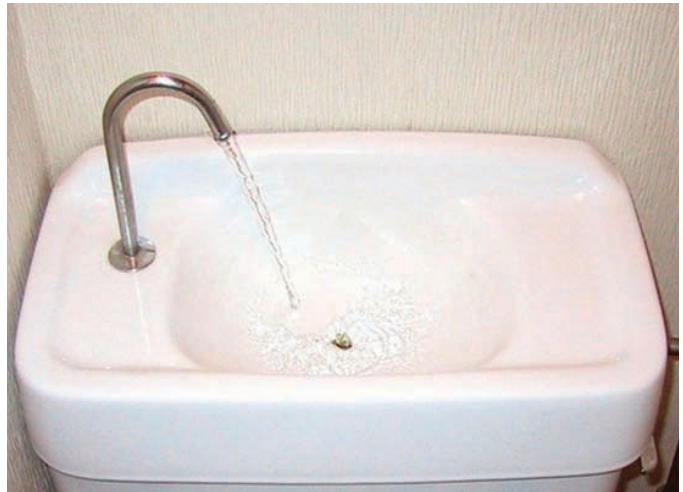
أداة لتوفير الماء في مرحاض ياباني: ملء خزان (سيفون) دقيق المرحاض أثناء غسل يديك. المصدر: Wikimedia Commons
