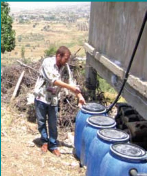
أربعة براميل بلاستيك (PE) تصل بينها أنابيب بلاستيك (PVC) تشكل وحدة معالجة المياه الرمادية. البرميل الأول يفصل الشحوم والزيوت والجواود، وكذلك يعمل كحجرة معالجة مسبقة أو أولية، حيث تترسب في أسفله الجواود التي تحملها المياه الرمادية، وتطفو على السطح المكونات الخفيفة مثل الشحوم ورغوة الصابون. هذا البرميل مزود ببطاء واسع يسمح بتنظيفه من المواد الطافية والترسبة.
