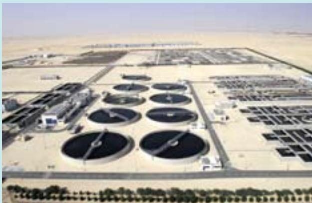
اغشية للتنقية. وتناسب المياه من معمل الترشيح الفائق الدقة إلى معمل التناضج العكسي الذي يتتألف من 6 خطوط للتنقية على 3 منصات. ويضم كل خط 7 منصات نقالة، ويبلغ مجموع أغشية التنقية في هذه المنصات 20832 غشاء. وتتضمن أغشية الترشيح هذه الإزالة التامة للمواد الصلبة المعلقة والجراثيم. تنتقل المياه المنقاة بعد ذلك إلى حوض التجمیع، ومنه تُضخ في خطوط أنابيب إلى منشأة وزارة الأشغال العامة في الصليبية.
